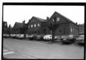
Skolbyggnaden sedd från öster
