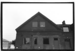
Detalj av SV-fasaden
