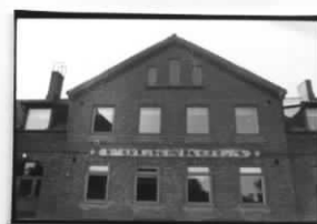
Detalj av SÖ-fasaden
